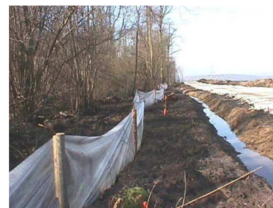
Figure 87: Exemple de barrières étanches temporaires à amphibiens
