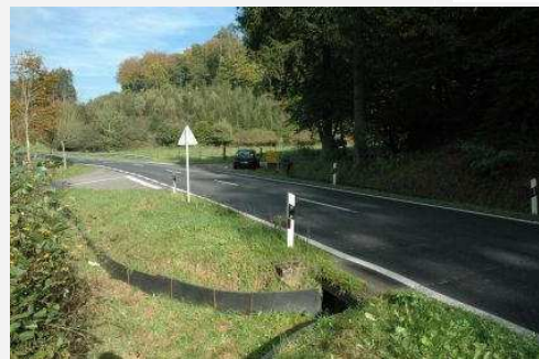
Illustration d'un entonnoir créé pour guider les amphibiens dans le crapauduc
